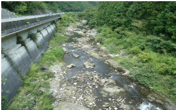
一級河川渡川水系 北川 川づくり実施後
