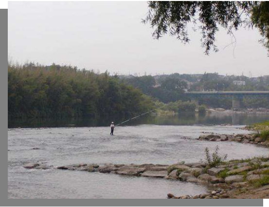
(矢作川、古巣地区の水制工)
