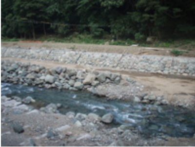
川幅を広げる工事だそうですが
