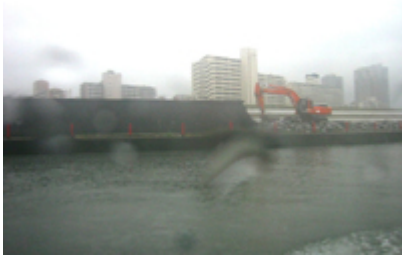
パラペット護岸を削っている様子。雨で見にくい写真ではありますが。
