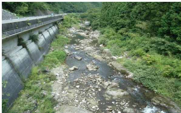
一級河川渡川水系 北川 川づくり実施後
